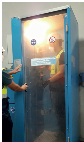
Fig. 6.1. Cabinas de limpieza de personal (Fuente: INS)
