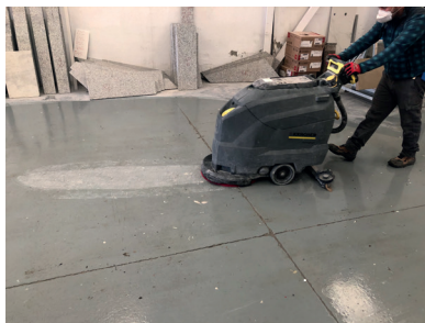
Fig. 6.3. Fregadora de suelos en marmolería (Fuente: INS)
