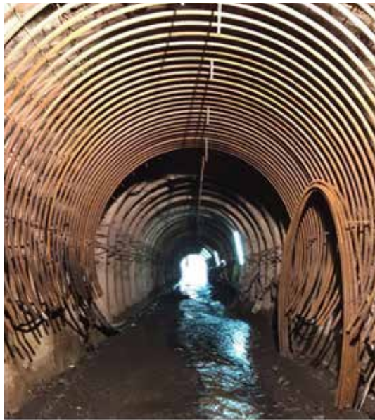
Parte superior armadura.
