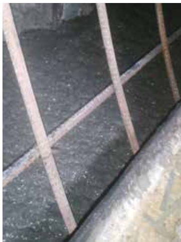
Vista del hormigón desde la ventana del carro encofrador.
