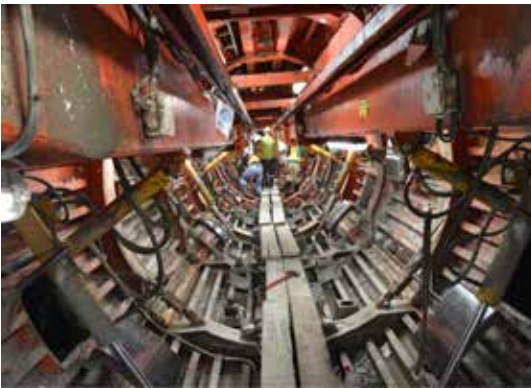
Vista interior del carro encofrador.
