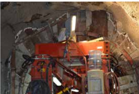
Tape de madera como encofrado.
