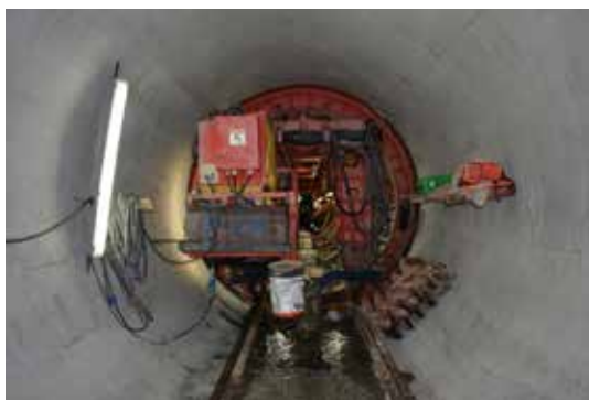
Módulos después de ser desencofrados.
