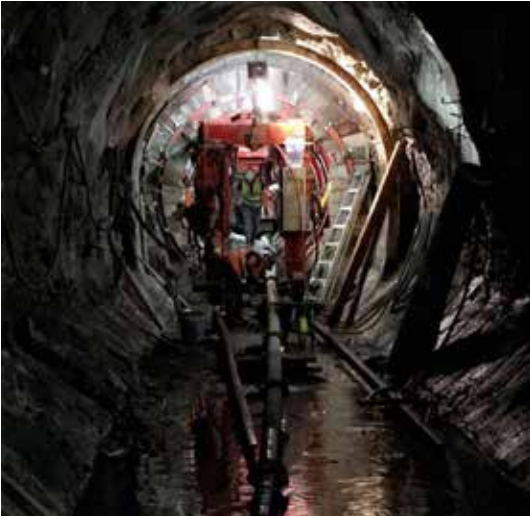
Limpieza de zona a hormigonar.
