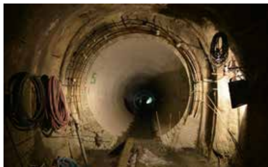
Finalización de revestimiento PK 2+246,95.
