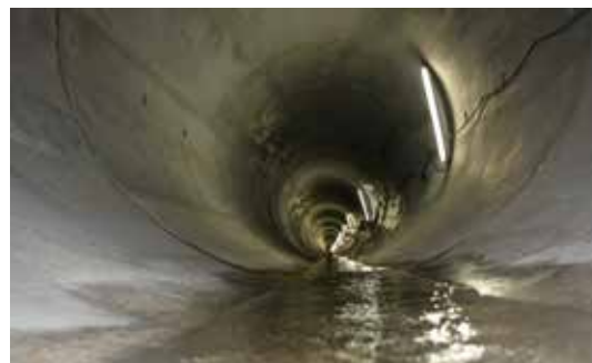
Vista general de zona revestida
