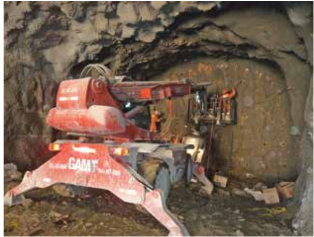
Instalación de cartuchos y explosivos dentro de los barrenos.
