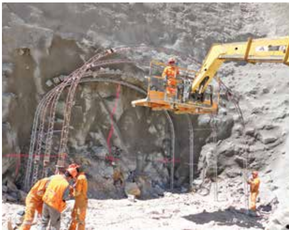
Los túneles han sido excavados mayoritariamente en riolitas y andesitas de buena calidad geotécnica, con un índice RMR normalmente superior a 50 puntos.
