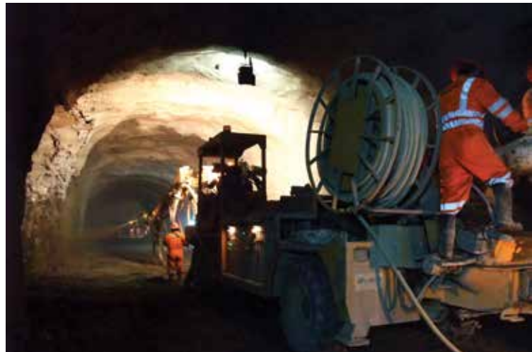
El sostenimiento se ejecutó mediante shotcrete con fibras de polipropileno, bulones y marcos metálicos
