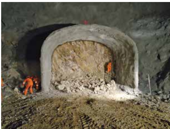
Los túneles han sido excavados mayoritariamente en riolitas y andesitas de buena calidad geotécnica, con un índice RMR normalmente superior a 50 puntos.
