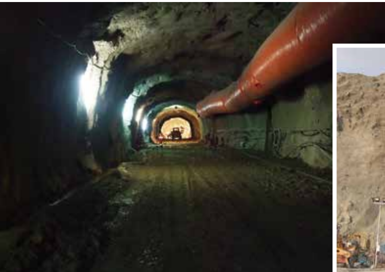
Vistas de la tubería de ventilación que aspira o impulsa los gases tóxicos producidos por los explosivos.
