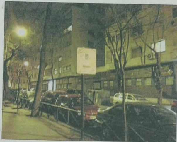
La calle de Fuenterrabía en su conexión con la de Torrejón presenta falta de iluminación.
